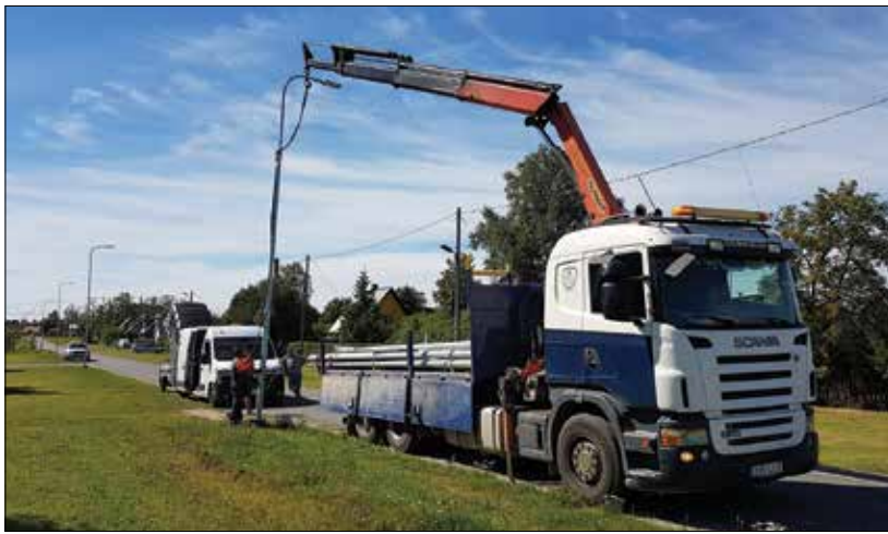
Установка новых опор освещения на бульваре Таара.
