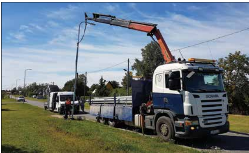
Uute valgustustornide paigaldamine Taara puiesteel
