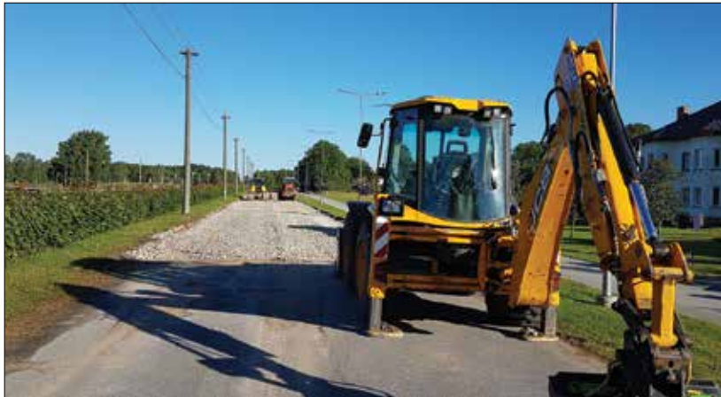
Ремонтные работы на участке Пайдеского шоссе в Тамсалу.
