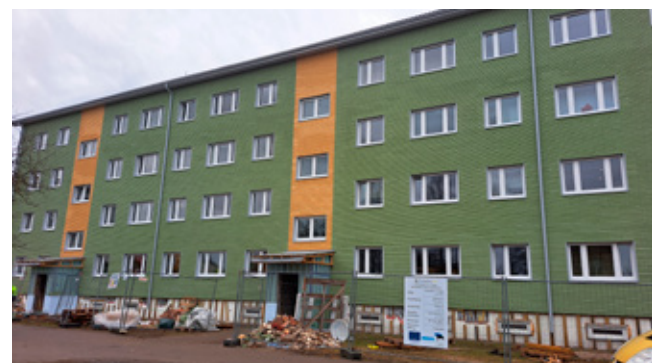
Roheline tn 12 hoone renoveerimine võtab ilmet. Foto: Kuido Merits
