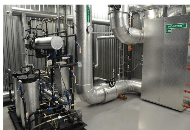
Fotod 1. Tapa Üleviste katlamaja, koos hakkepuidu lao ja -katlaga, õlikatla ja soojusvahetiga
