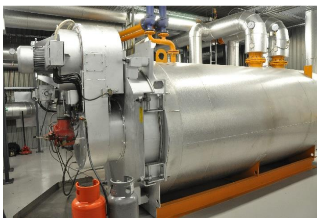
Fotod 1. Tapa Üleviste katlamaja, koos hakkepuidu lao ja -katlaga, õlikatla ja soojusvahetiga
