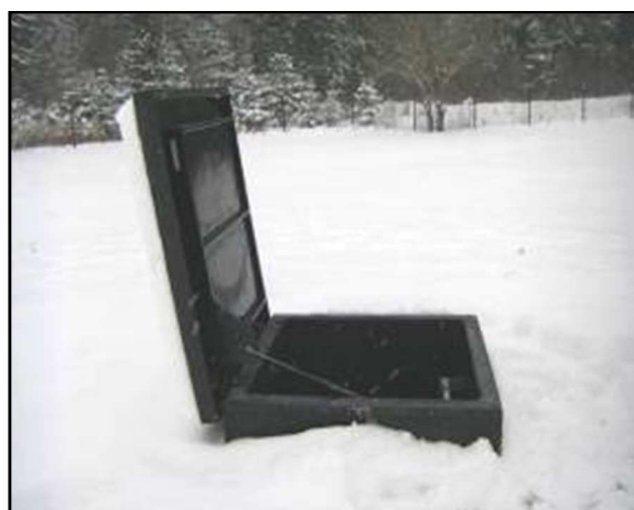
Joonis 4.5 Uus I puurkaevu päiseosa
