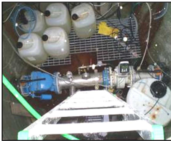
Joonis 4.4 Moe II veehaarde puurkaevu nr 19693 (3) päiseosa ja veemöödusõlm
