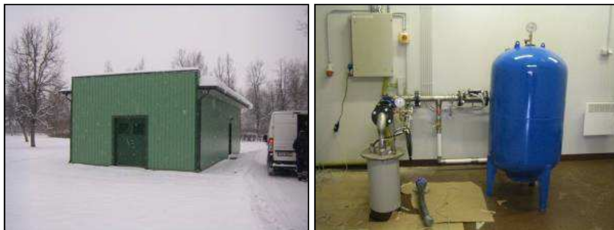
Joonis 4.6 Eha puurkaev-pumpla välis- ja sisevaade
