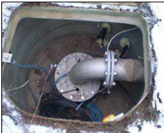
Joonis 4.4 Moe II veehaarde puurkaevu nr 19693 (3) päiseosa ja veemöödusõlm
