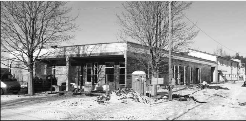
В Лехтсе строительные работы идут полным ходом.
