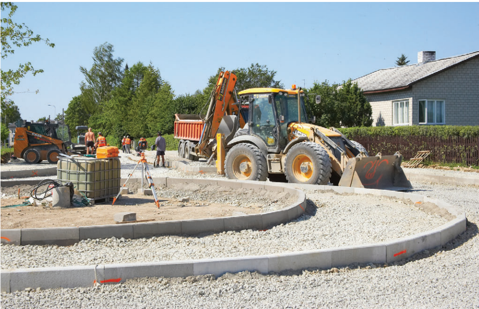
Suuremad eeltööd on tehtud ja kohe-kohe hakatakse asfaldi panema Foto: Aavo Leemets
