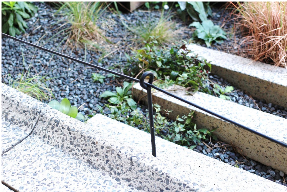
Foto 11. Näide pulbervärvitud terasest. Maapinda ankurdatud metallpiire haljastuse kaitseks.
