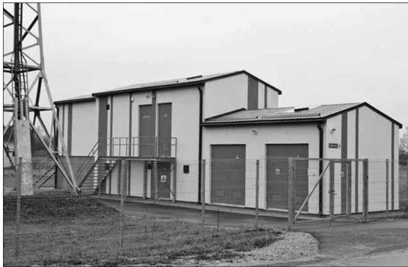
Новая подстанция в Тамсалу «служит» также и тапскому региону.
