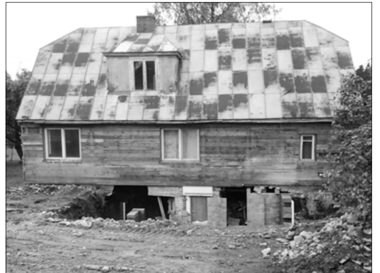
Владелец этого дома проводит ремонтные работы в особенно «безопасных» условиях. Фото из архива Тапаской волостной управы
