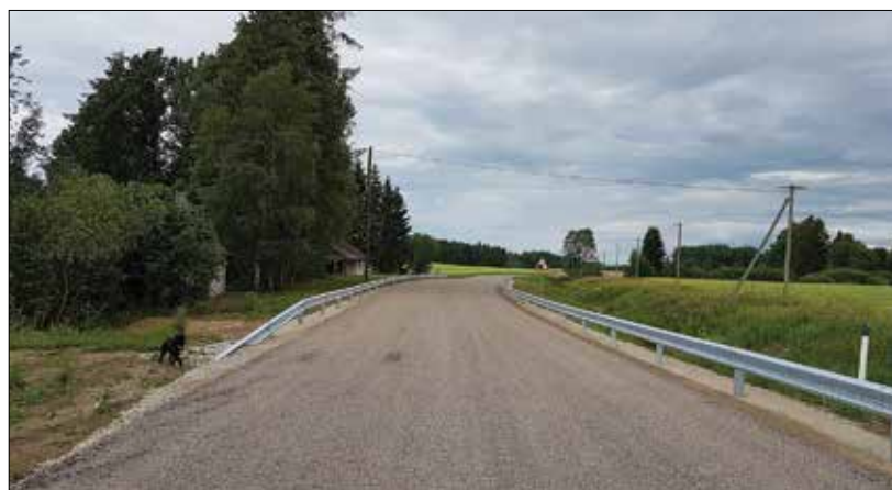
Дорога Ляпи – Ару – Оякюла.
